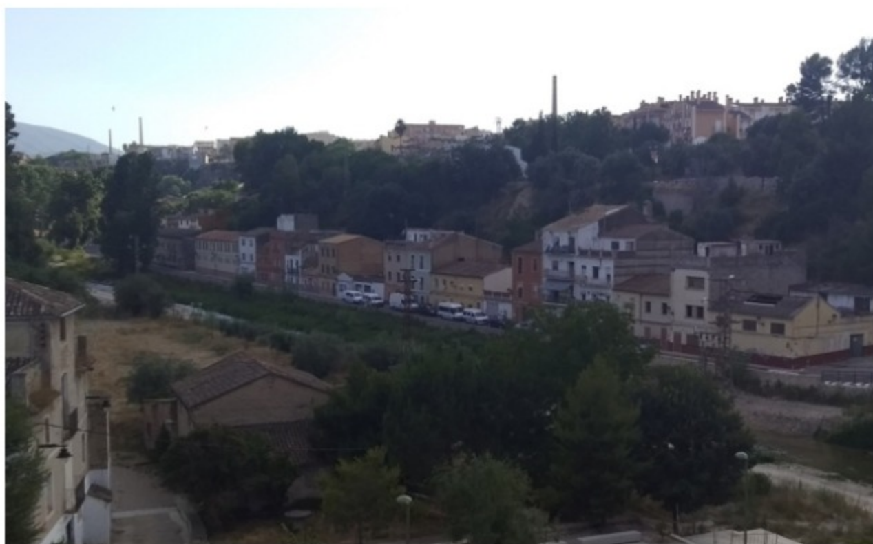
Vista general de Cantereria con el talud tras las viviendas que serán derribadas. / B.G.
