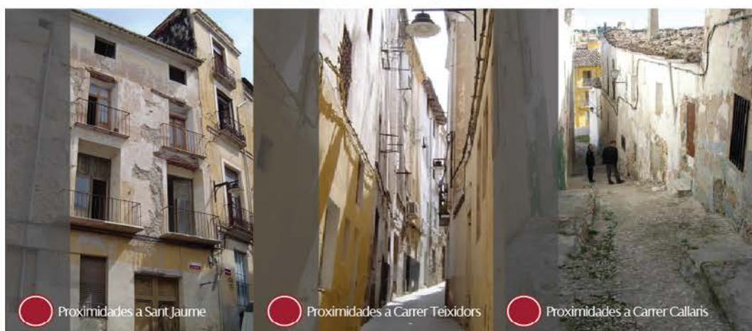
Imagen. Estados de los edificios en el Centro Histórico
